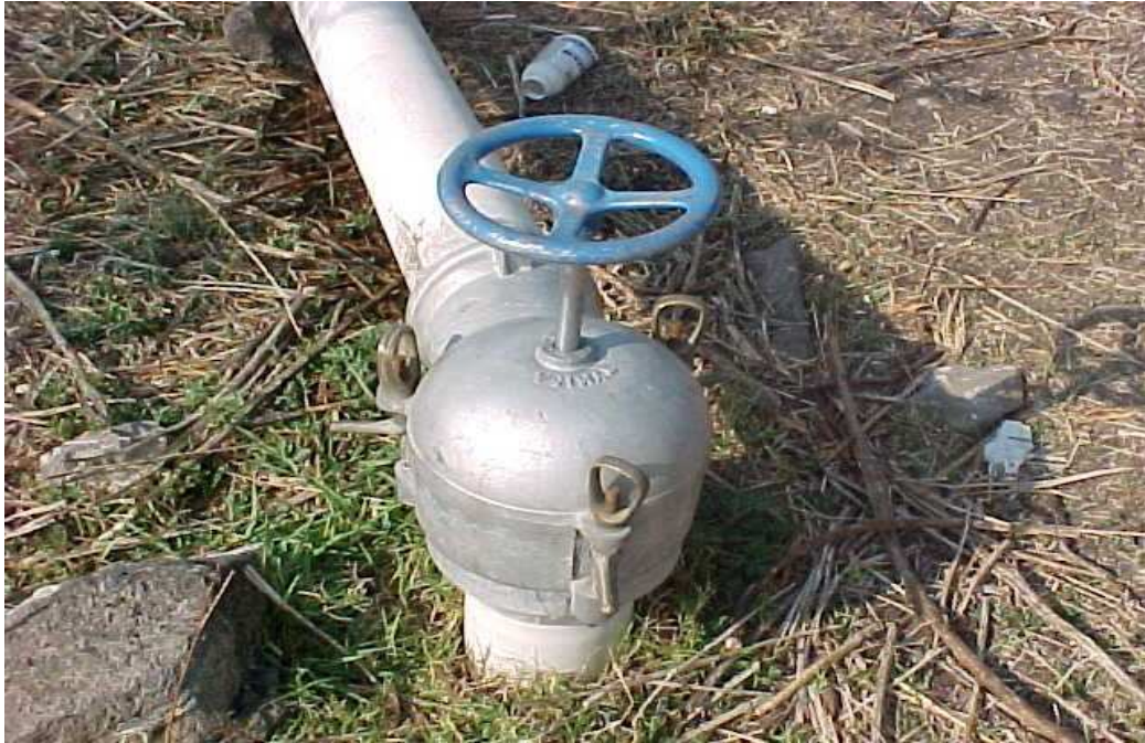
FIG. 1.19 – Infrastructure des puits : bouches d'eau à l'entrée de la parcelle (Photo : PAR)
