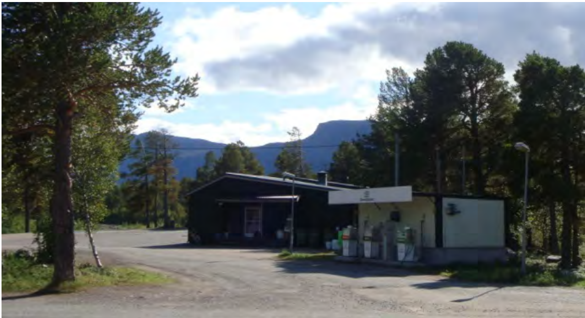
Photo 69. Station d'essence et bâtiment principal de Stora Sjöfallet. Photo : F. Revelin.
