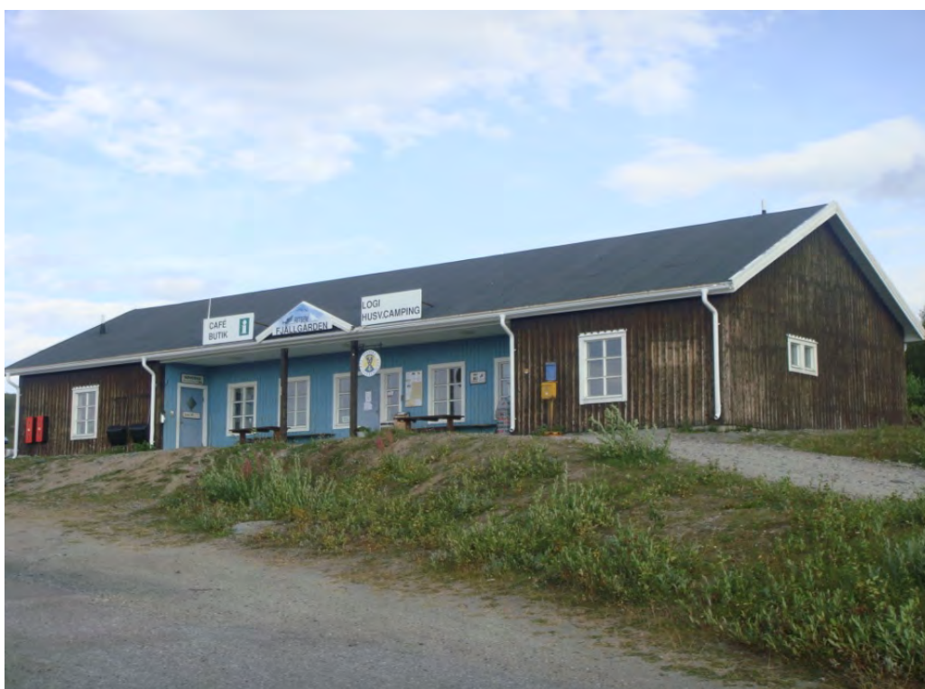
Photo 67. Bâtiment principal de la station de Ritsem. Photo : F. Revelin.
