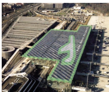
ill. 133. De nouvelles expérimentations réalisées avec notamment des architectes, pour différents besoins de l'aéroport, comme par exemple un hôtel.
