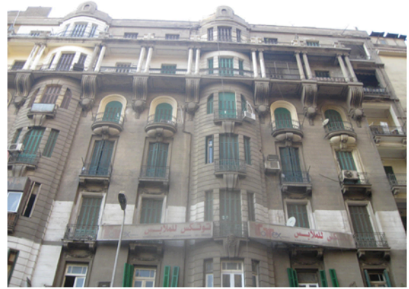
Figure 49. L'îlot comprend deux immeubles en état général assez bon, où se trouvent les bureaux de Al Ismailia. L'immeuble de façade, R+7 a subi plusieurs transformations avec des surélévations.
