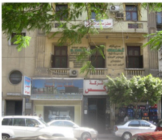
Le passage couvert et les boutiques en RDC.
