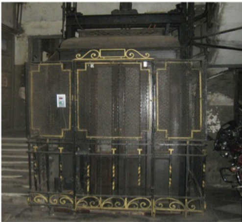
Les détails de l'immeuble
