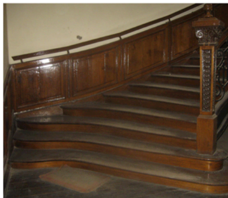
Les détails de l'immeuble
