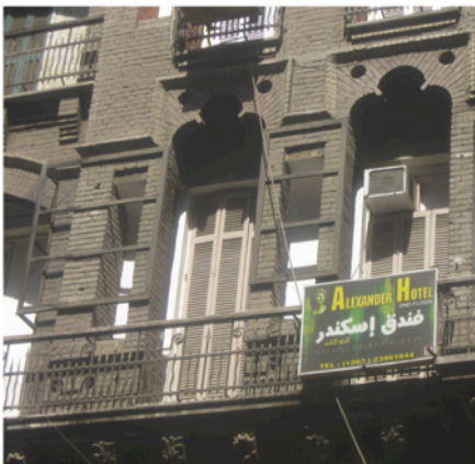
Les détails de l'immeuble
