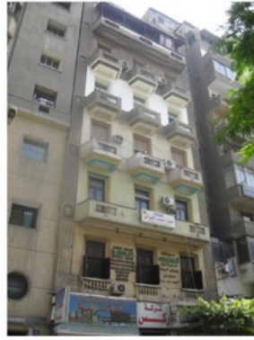
8. Immeuble rue Adly
