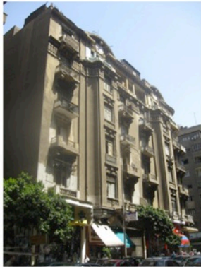
7. Immeuble angle rue Sherif
