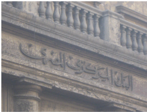
Les détails de l'immeuble
