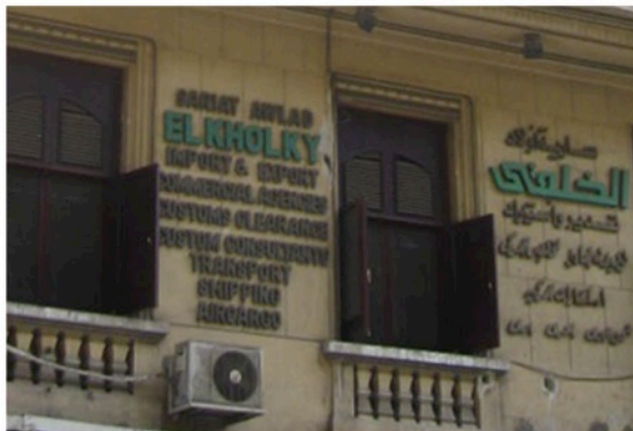
Les détails de l'immeuble
