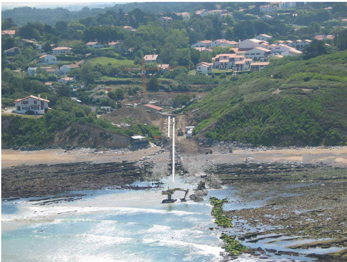
Construction du collecteur de 400 m de long, plage de Cenitz. Photo Mairie de Guéthary
