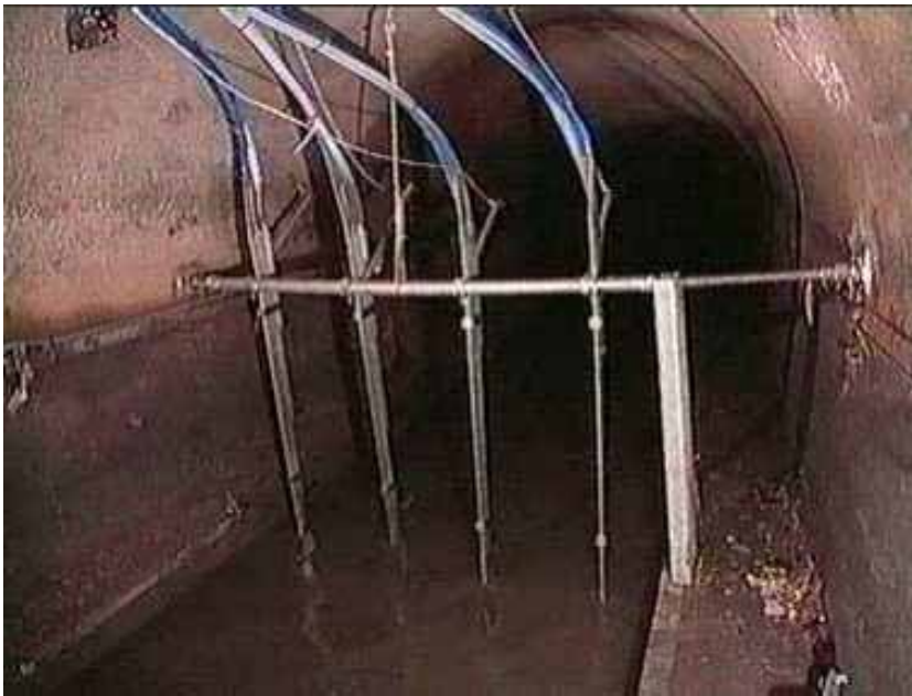
(a) faisceaux en cours d'abaissement
