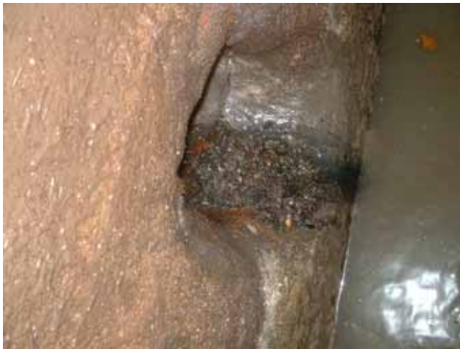
a) b) branchement sur le collecteur principal
