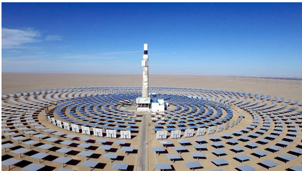
Figure 1: Centrale solaire thermique en Chine. Les rayons du soleil sont renvoyés au niveau de la tour où se trouve le fluide caloporteur. [3]
