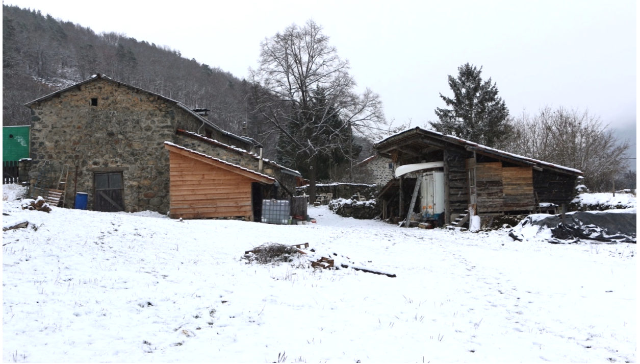
Image 35 : Ferme, bâtiment collectif et abris bois.
