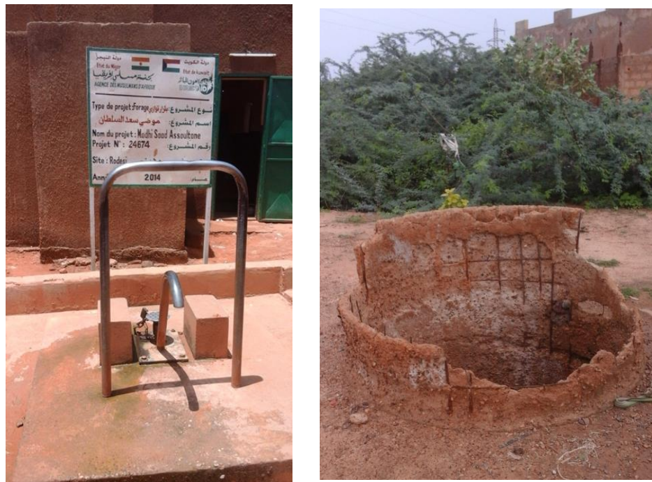
Photo n° 13: a) Une pompe à motricité humaine offerte par une association islamique internationale installée devant la mosquée à Tondigamey ; b) un puits du quartier Diamwoyé (arrondissement 5) en mauvais état sous l'effet de la pollution chimique attaquant même le ciment mais qui n'empêche pas les habitants de puiser l'eau de cet ouvrage pour les besoins domestiques.
