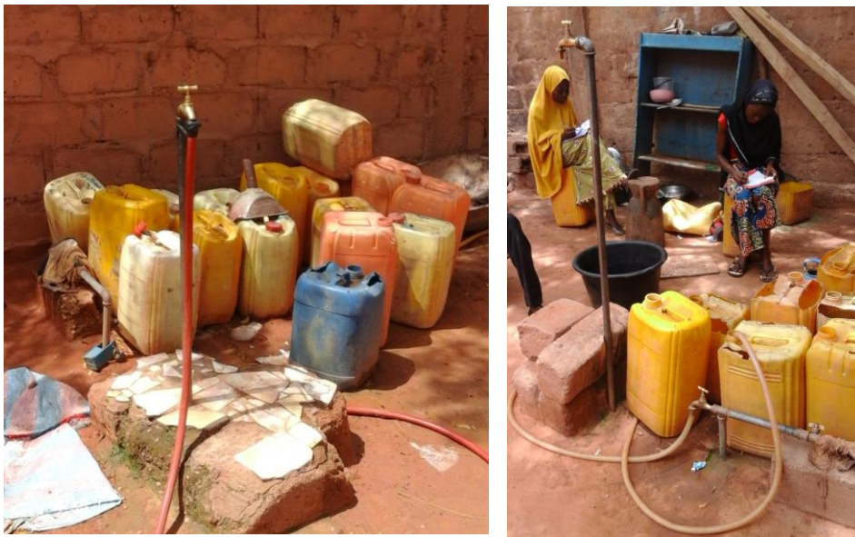
Photo n° 14 : Des bidons de sécurité à côté du robinet à Tondigamey et à Banizoumbou 2 où le robinet est abaissé pour extraire l'eau contenue dans les tuyaux la journée.
