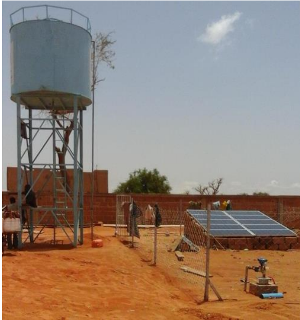
Photo n° 8: a) un forage de Qatar Charity, on peut bien voir le panneau solaire assurant l'énergie pour le fonctionnement. ; b) un forage de l'Organisation pour un Développement Humain (ODH)
