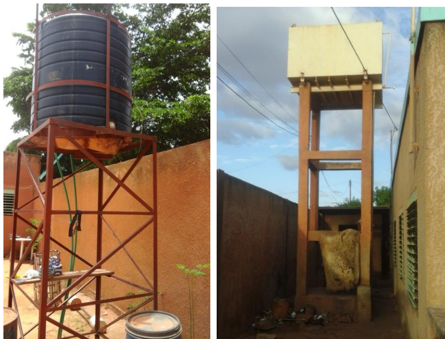
Photo n° 15 : Réservoirs de sécurité pour faire face aux intermittences quotidiennes, les réservoirs en caoutchouc sont récents.
