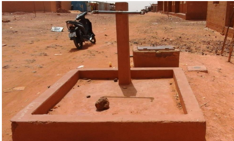
Photo n° 21: Modèle de terrasse « imposé » pour les BF
