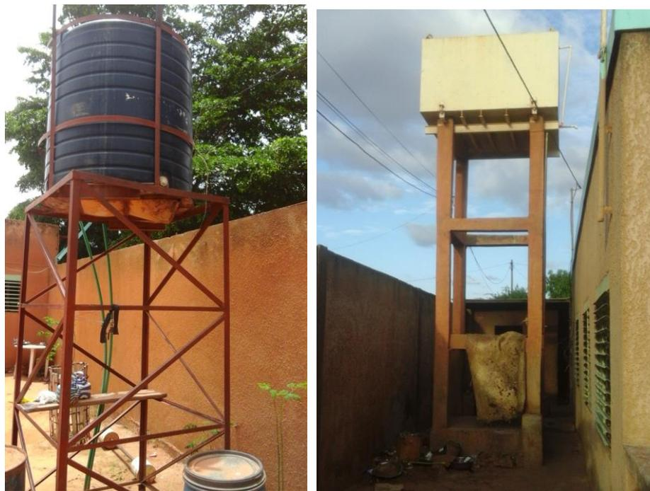
**Photo n° 15** : Réservoirs de sécurité pour faire face aux intermittences quotidiennes, les réservoirs en caoutchouc sont récents.
