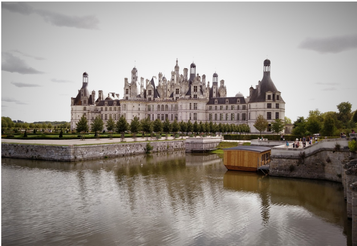
FIG. V.8 : Vue d'ensemble du Château de Chambord en juillet 2019.
