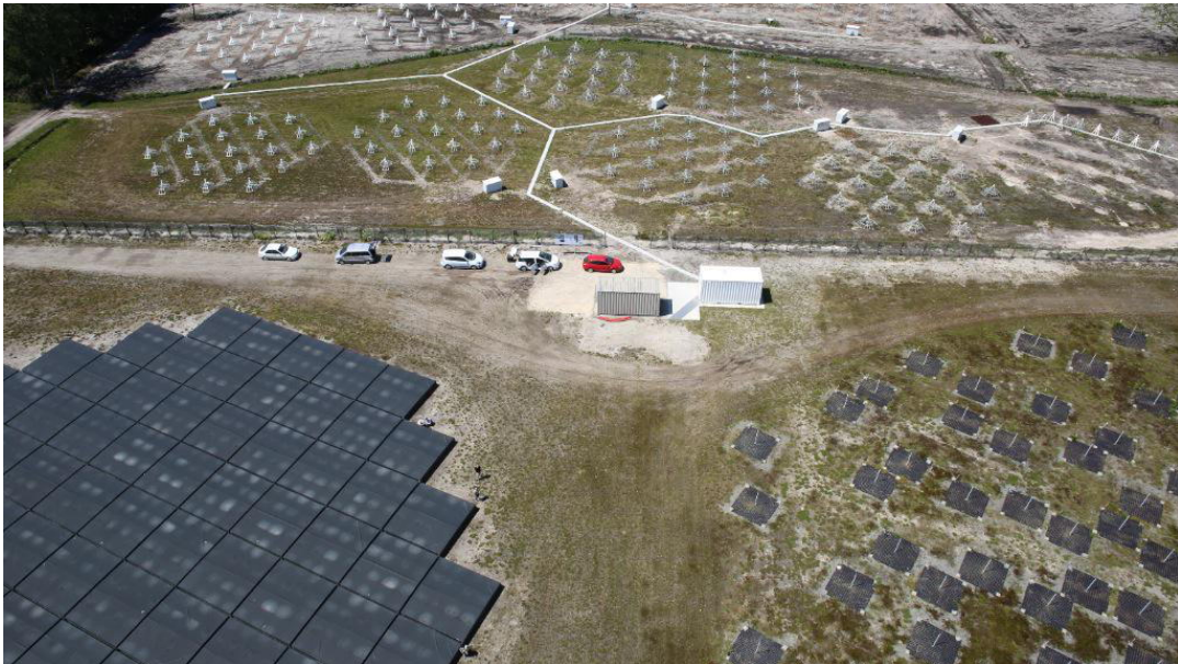
FIGURE 6.5 – Photographie aérienne de la station internationale LOFAR de Nançay (FR606) avec les antennes LBA en bas à droite, HBA en bas à gauche, ainsi que NenuFAR dans la partie haute. L'image provient de https://www.obs-nancay.fr/-NenuFAR-45-.html .
