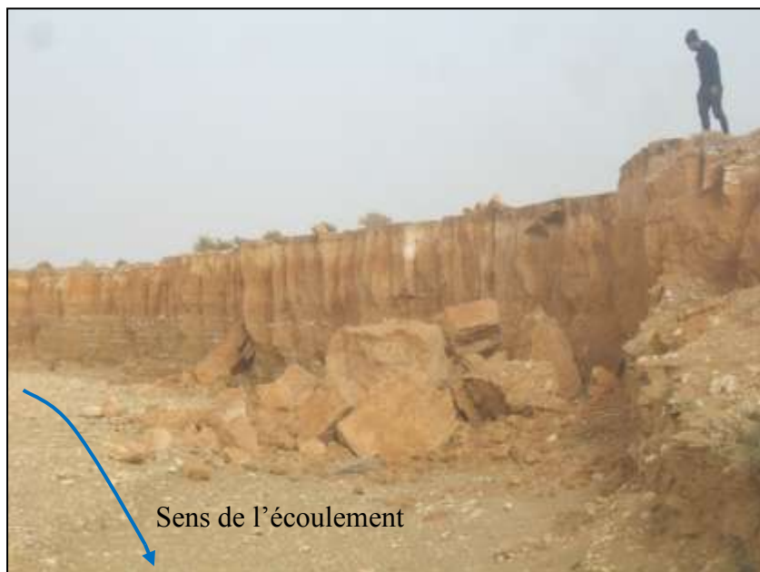
Photo n°. 54: Sapement latéral suivi d'éboulement post-crue sur la berge gauche de l'oued El Miit
