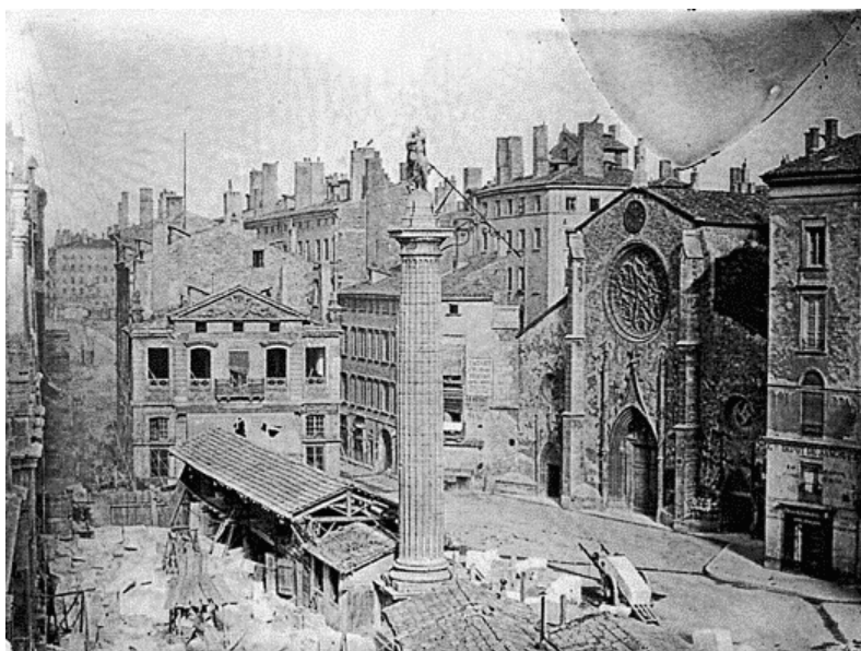
Illustration 9 : Démolition de l'hôtel du Concert, 1856
