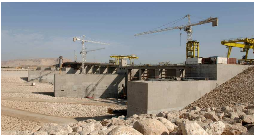
Figure II-14 : Vues du barrage de Naga-Hammadi en cours de construction
