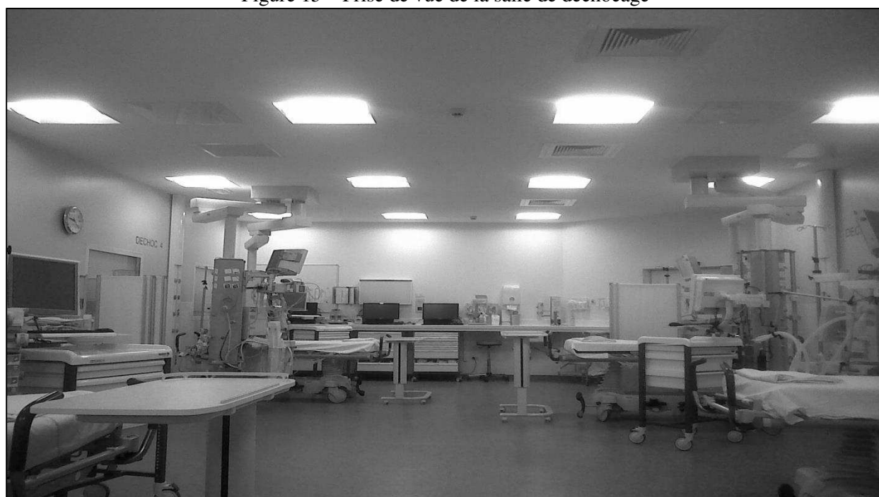
Figure 15 – Prise de vue de la salle de déchochage
