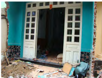
Étape 2 : Les riverains entreprennent les travaux de recul de leur façade
