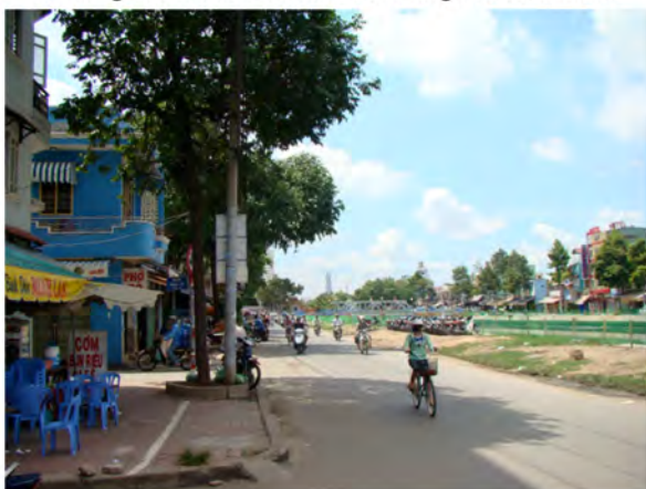
Les berges du canal en cours d'aménagement en 2010
