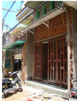
Étape 2 : Les riverains entreprennent les travaux de recul de leur façade
