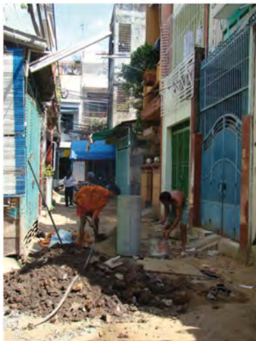
Étape 3 : La société de construction engagée par les autorités publiques entreprend les travaux de voirie : de la pose du réseau d'égout à la surélévation du niveau de la ruelle lors de son revêtement
