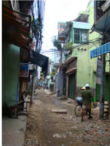
Étape 1 : La pose des jalons d'élargissement et la mise à nu de la chaussée et des bouches d'égout
