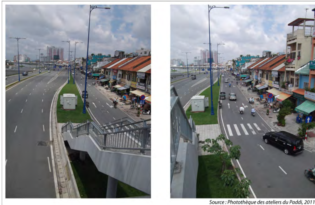
Illustration 26. Les attributs d'un boulevard urbain : une passerelle piétonnière et la présence d'une contre-allée latérale dans le tronçon central (district 1)
