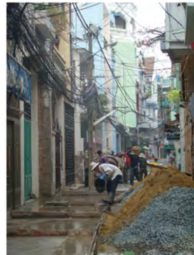
Étape 3 : La société de construction engagée par les autorités publiques entreprend les travaux de voirie : de la pose du réseau d'égout à la surélévation du niveau de la ruelle lors de son revêtement
