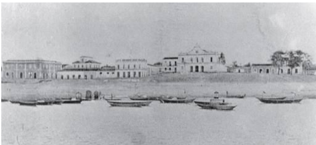
Figure 21: Le centre-ville de Santarém et ses institutions, depuis le port, en 1898
