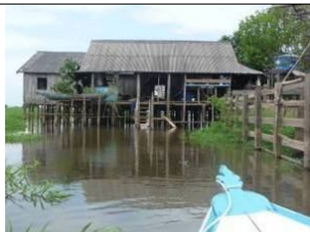
Maison en bois et tôle sur pilotis ©Photo Corinne Choulet
