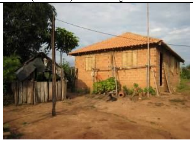
Maison en briques et tuiles, volets en palmes, Garimpo (août 2012) - ©Photo B. Choulet
