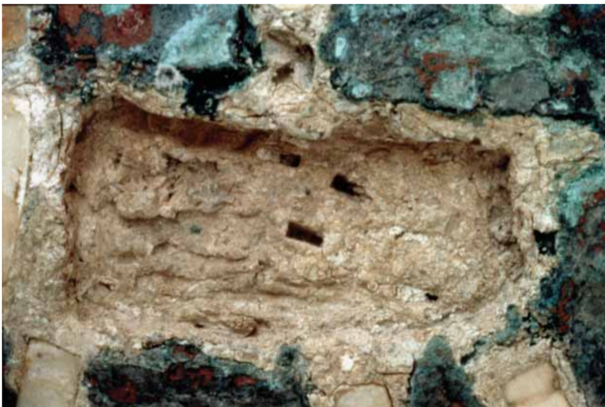
Figure 68 : photographie de détail en cours de restauration d'un fragment de coquillage détaché. De petits trous rectangulaires disparaissent dans le plomb à l'arrière des fragments de coquillage.
