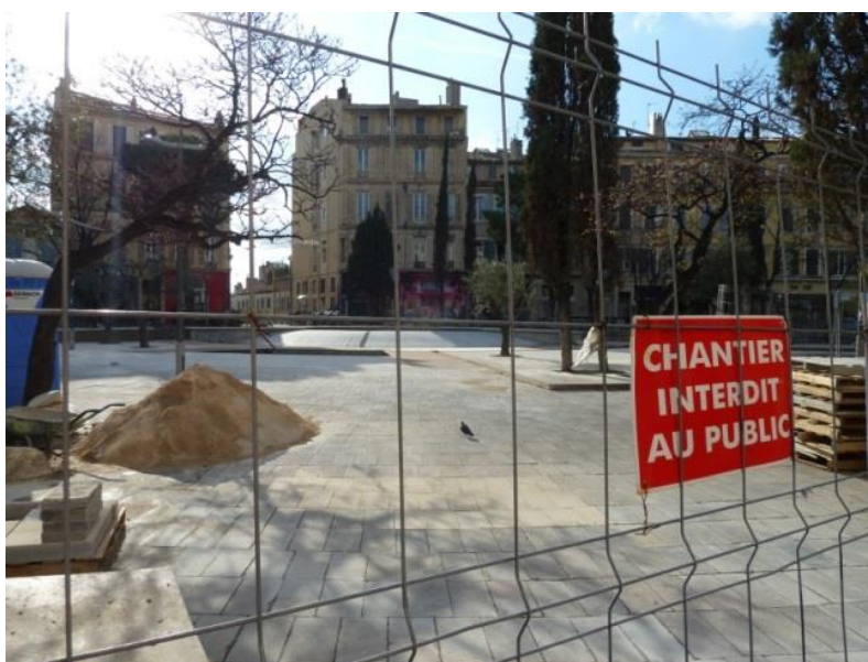
Photographie prise le 9 avril 2013 : le centre de l'esplanade du cours Julien en travaux
