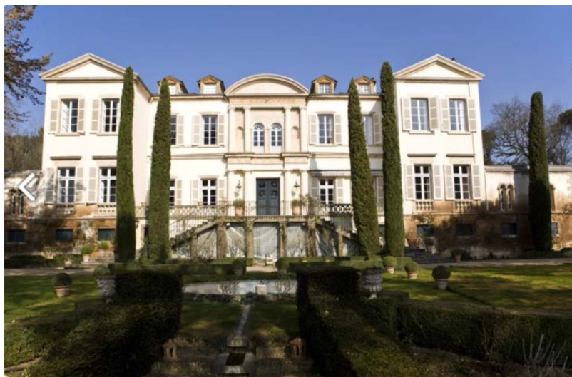
Photo 3 - Lisle-sur-Tarn (Tarn), château viticole dit château de Gineste ou château de Sours / Référence : IVR73_20118150580NUCA - La façade sud. - Poitou, Philippe, @ Conseil général du Tarn ; @ Inventaire général Région Midi-Pyrénées, 2011
