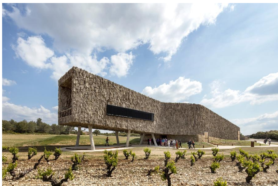
Photo 17 - Château Castigno, murs extérieurs recouverts de liège - www.tourismecanaldumidi.fr
