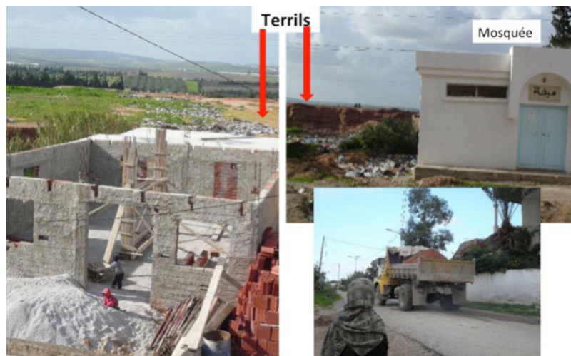
Image 19 : Nouvelles constructions à Jebel Ressas. Tunisie (Crédit photo. S. Becerra, 2011).
