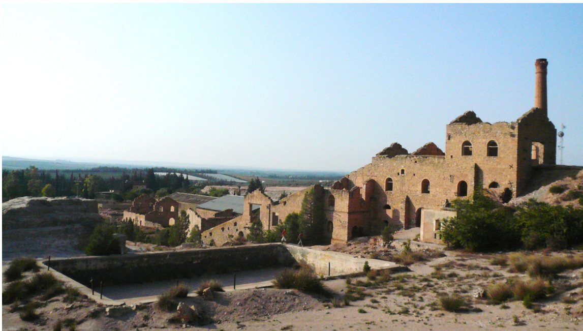
Image 20: Vue sur l'ancienne laverie de Jebel Ressas, Tunisie (crédit Photo. : S. Becerra 2008).
