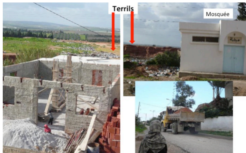
Image 19 : Nouvelles constructions à Jebel Ressas. Tunisie (Crédit photo. S. Becerra, 2011).
