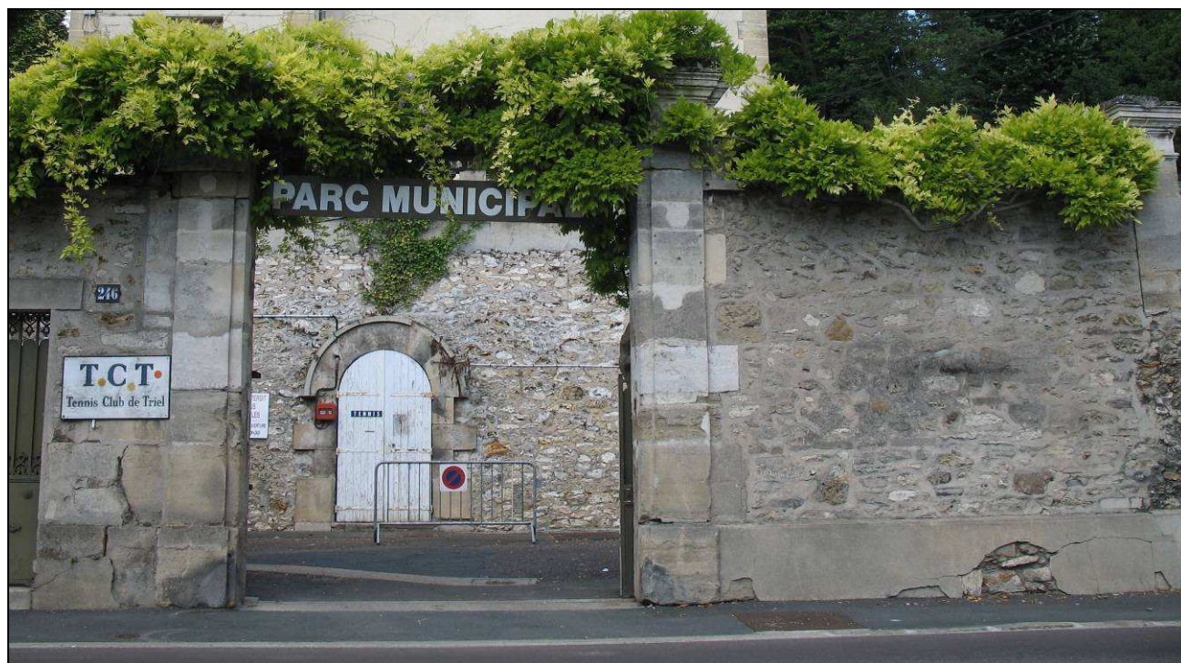
Figure 52 : Une des portes du jardin (f) transformé aujourd'hui en parc municipal
