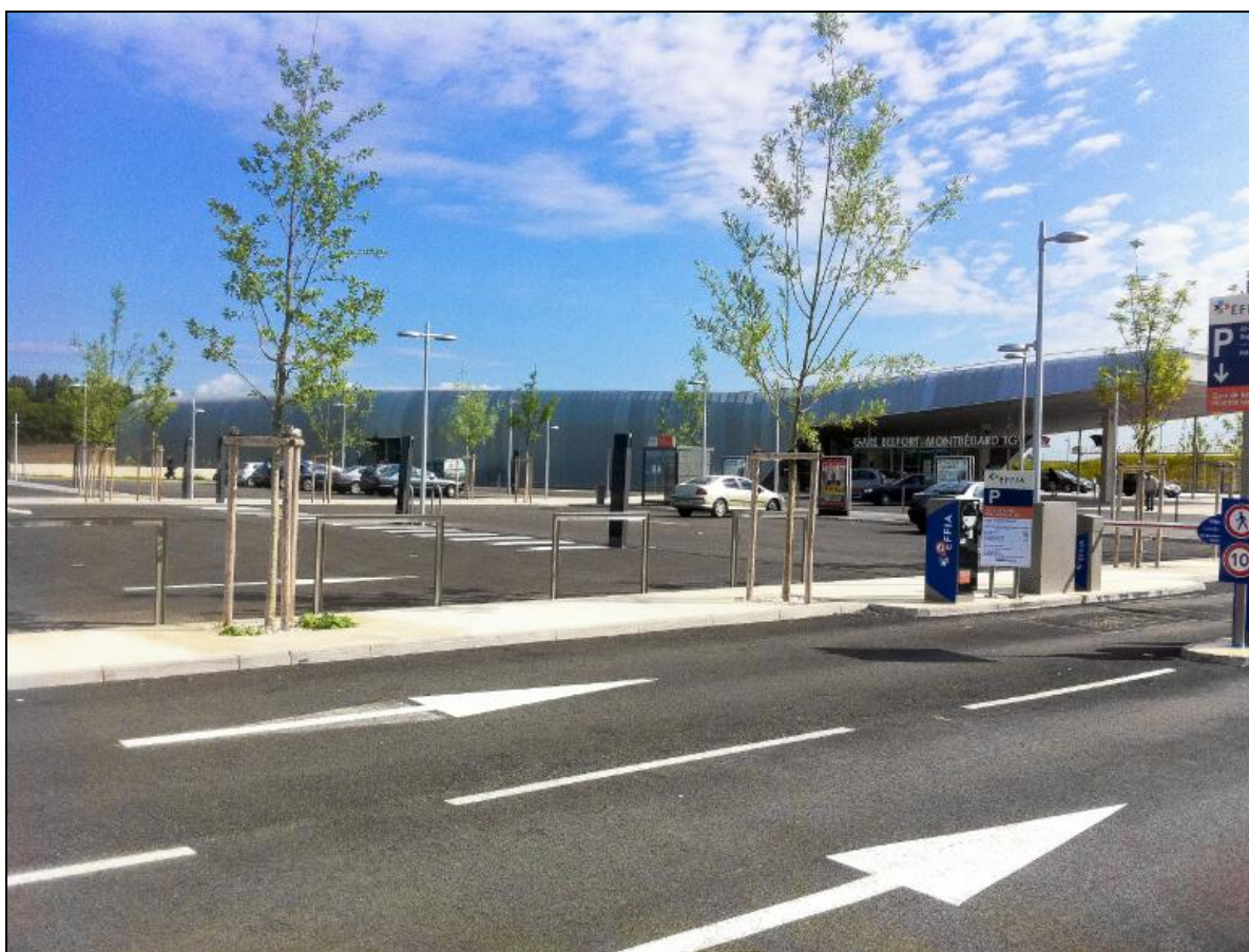
Figure 3 - 57 Le bâtiment voyageur de la gare Belfort-Montbéliard TGV (10/07/2012)
