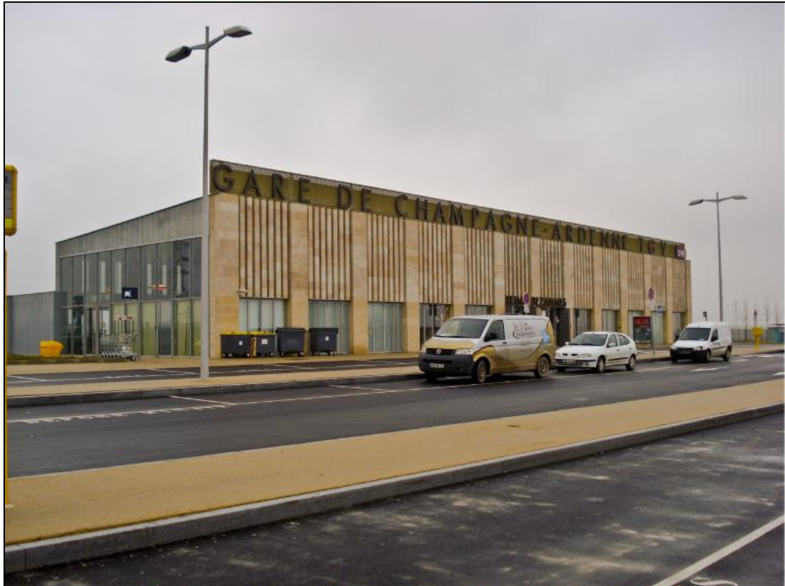
Figure 3 - 48 La façade de la gare Champagne-Ardenne TGV (4/02/2008)
