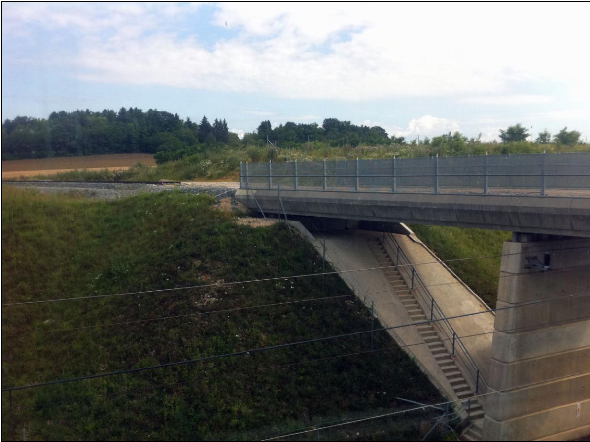
Figure 2 - 29 L'emplacement de la future ligne Belfort-Delle au-dessus des voies TGV (9/07/2012)
