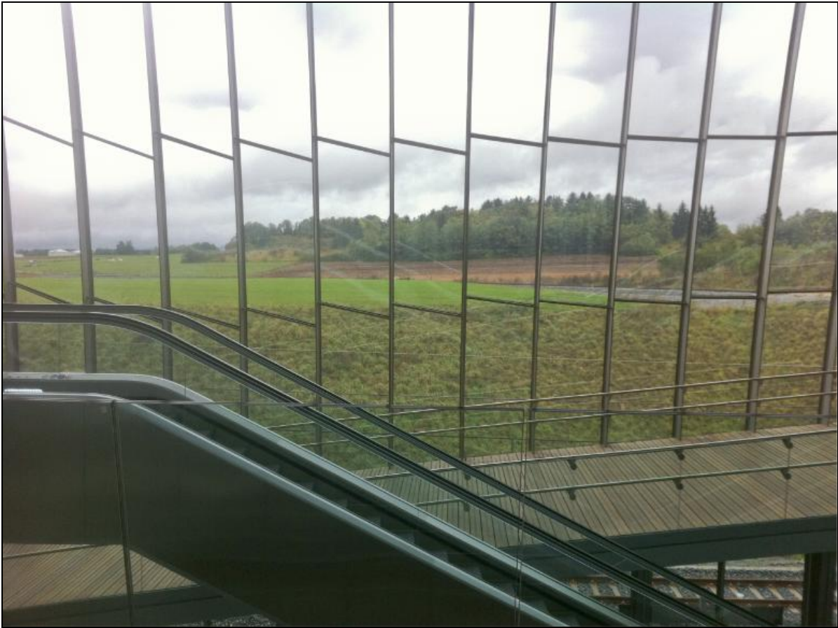
Figure 3 - 58 Le paysage visible à partir de la baie vitrée (08/10/2012)
