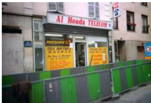
Rue Myrha, Al Houda telecom
