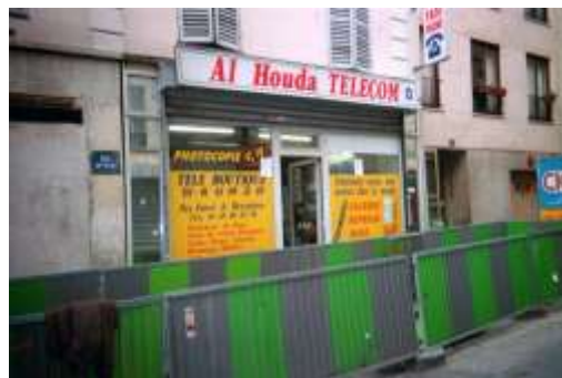
Rue Myrha, Al Houda telecom
