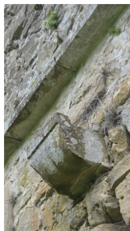
Mur nord de l'église : corbeau soutenant le toit du cloître
