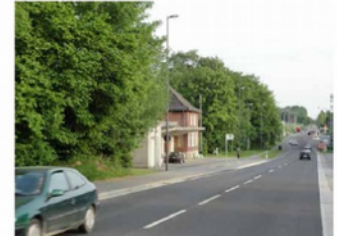
Grensvergang Duikland-Deijdt, Capener Straal en de Aachener Straal, Nijlhen 2011
