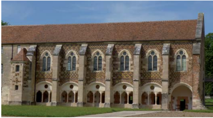
Fig. 133 Cîteaux, Abbaye. La bibliothèque et la galerie nord du petit cloître, état actuel (2018)
