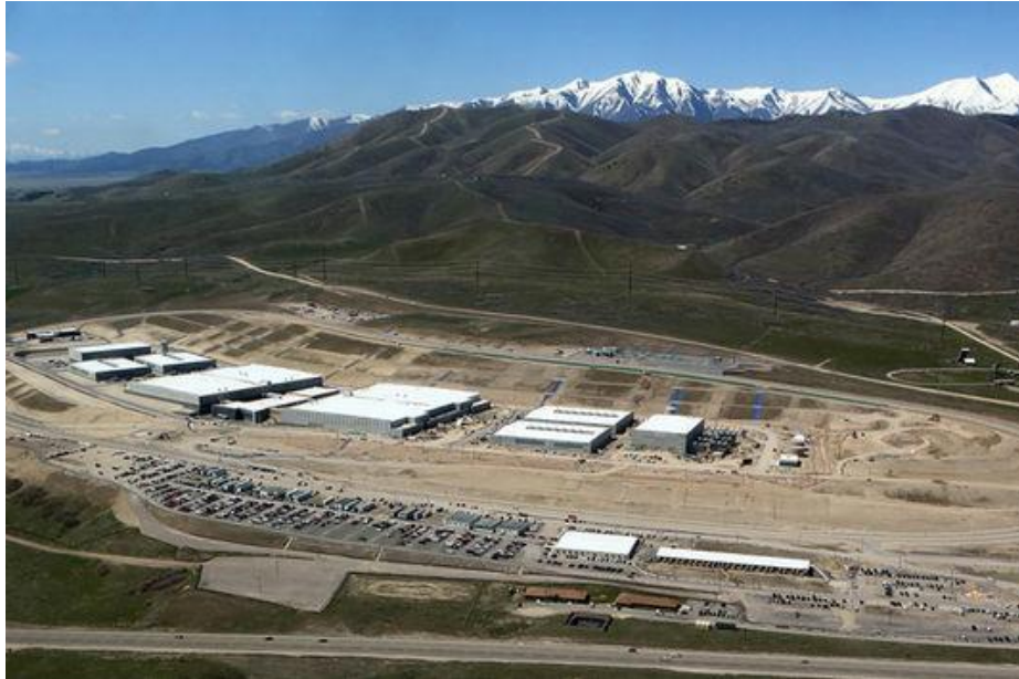
Figure 131 Le data center de l'Utah en construction Le Monde du 27/8/13
