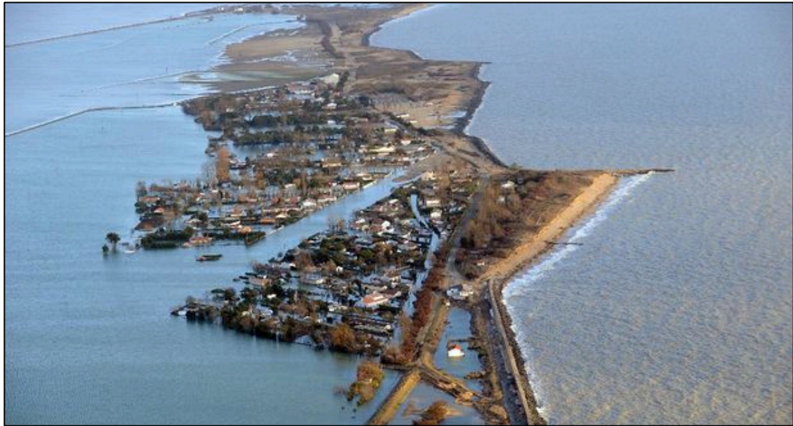
Figure 17 : La tempête Xynthia causant la destruction des digues en 2010 ©Philippe Chere
