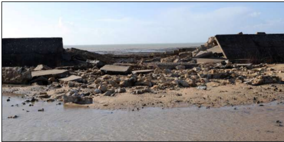
Figure 24 : Vue des digues à Saint-Martin-de-Ré après le passage de Xynthia ©AFP Xavier Leoty
