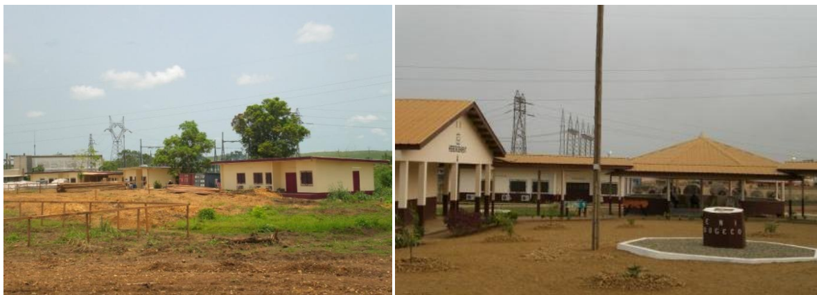
PHOTO 47 : VUE D'UNE PARTIE DE LA BASE VIE DE SOGECO À LOUDIMA, MARS 2009 ET AOÛT 2010.
