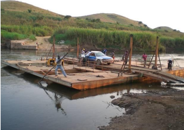
PHOTO 73 : LE BAC DE MABOMBO (EN BASSES EAUX). SON PONT EST INONDÉ EN HAUTES EAUX, QUAIS ET FILS SUBMERGÉS (OB_56). IL DEVRAIT ÊTRE RÉHABILITÉ PAR LE FONDS ROUTIER. INSCRIT AU BUDGET D'INVESTISSEMENT DE L'ÉTAT 2010, LE PONT, EN FER, SERAIT DÉJÀ COMMANDÉ EN ARGENTINE.
