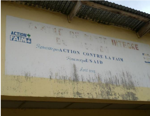
PHOTO 31 : BÂTIMENT DU CSI DE MABOMBO RÉHABILITÉ PAR ACF EN AOÛT 2002 SUR UN FINANCEMENT USAID (PHOTO 2010).
