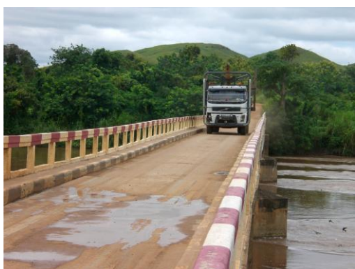
PHOTO 50 : GRUMIER (VIDE) SUR LE PONT DU NIARI, 2010
