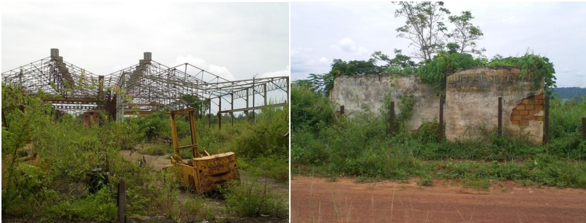
PHOTOS 19 : LA GARE DE MAKABANA ET LE « BUFFET DE LA GARE », À L'ABANDON (2009). BÂTIMENTS ET TÔLES ONT ÉTÉ BOMBARDÉS ET PILLÉS.
