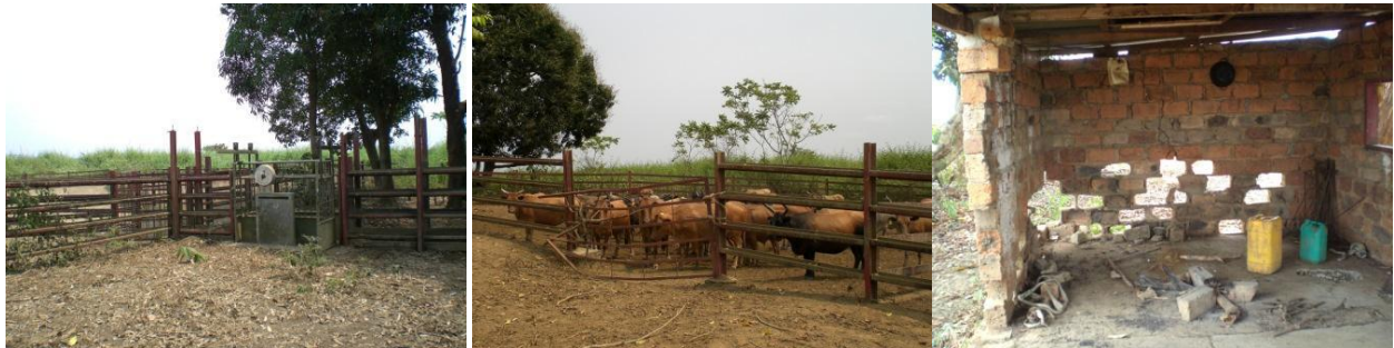
PHOTOS 108 : INFRASTRUCTURES DU CAT. LA BALANCE, HORS D'ÉTAT, ET LE COULOIR DE TRI ; LE PARC ZOO-SANITAIRE ; L'ANCIENNE INFIRMIERIE VÉTÉRINAIRE (2010).
