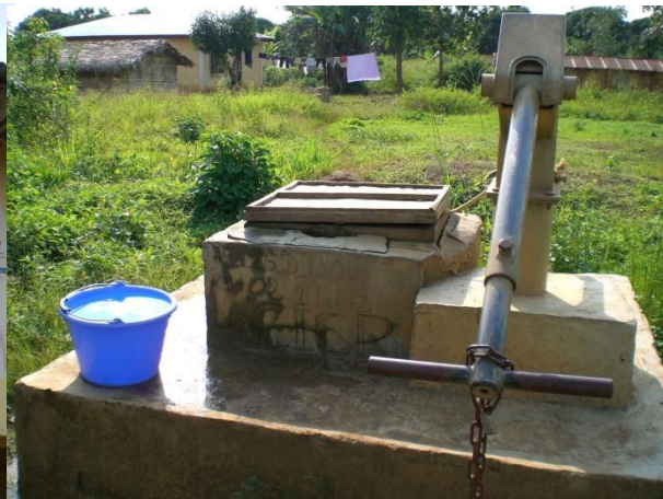
PHOTO 32 : PUIS CONSTRUIT PAR LE CICR À KINGOUÉ, EN SEPTEMBRE-OCTOBRE 2002 (PHOTO 2009).
