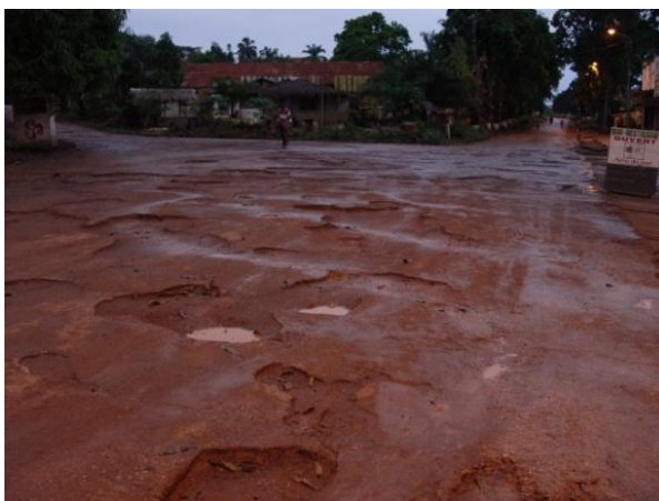
PHOTO 23 : LA VOIRIE URBAINE DE DOLISIE EN 2006 (CLICHÉ DGGT).
