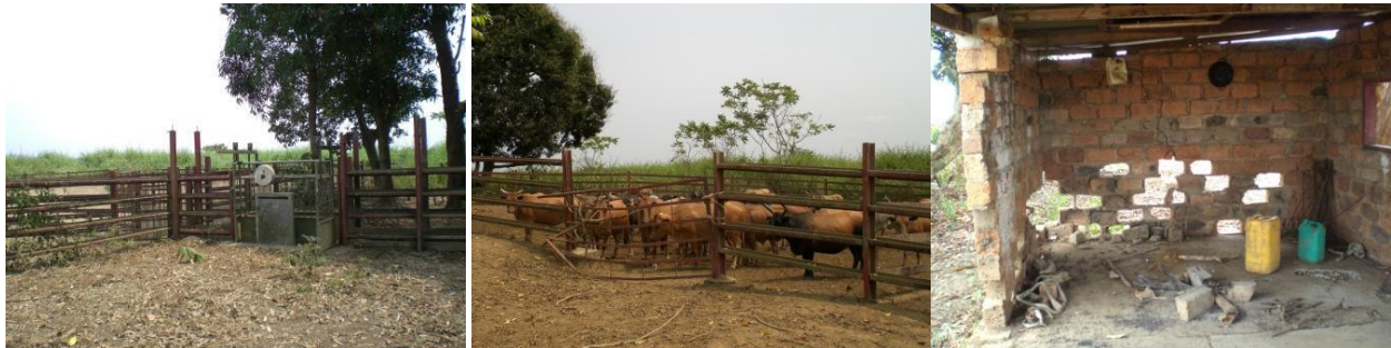
PHOTOS 108 : INFRASTRUCTURES DU CAT. LA BALANCE, HORS D'ÉTAT, ET LE COULOIR DE TRI ; LE PARC ZOO-SANITAIRE ; L'ANCIENNE INFIRMIERIE VÉTÉRINAIRE (2010).
