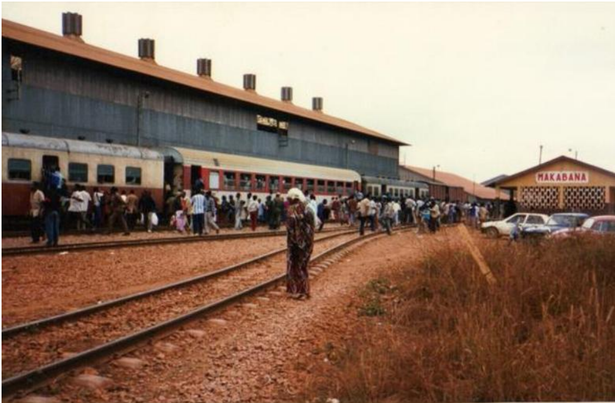
PHOTO 61 : LA GARE DE MAKABANA EN 1988 (PHOTO ROUSSEAU).
