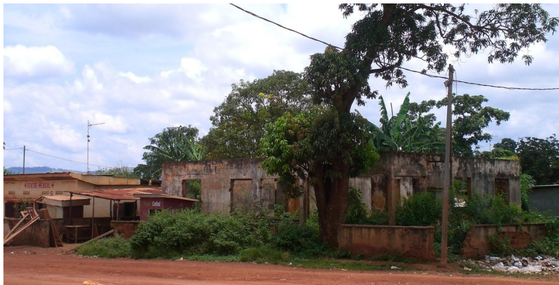
PHOTO 101 : MAISON DÉTRUITE À DOLISIE, 2009.
