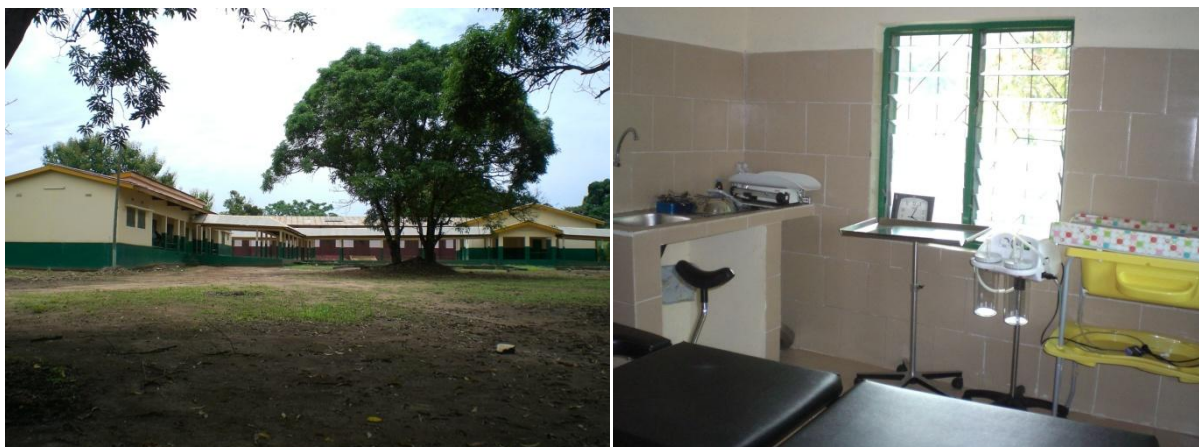
PHOTOS 91 : LE CSI DE KIBANGOU RÉNOVÉ PAR ENI (BÂTIMENTS VERTS) ; EN MARRON AU FOND, L'ANCIEN CSI ET NOUVEAU BLOC OPÉRATOIRE, RÉHABILITÉ PAR LA MUNICIPALISATION ACCÉLÉRÉE) ; MATERNITÉ RÉNOVÉE PAR ENI À KIMONGO.
