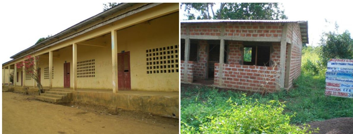
PHOTOS 34 : LE CEG DE ZANAGA RÉHABILITÉ PAR DES EX-COMBATTANTS DANS LE CADRE DU PNDDR (PHOTOS 2010). PROJET NON TERMINÉ AU CSI DE KINGOUÉ (PHOTO 2009).
