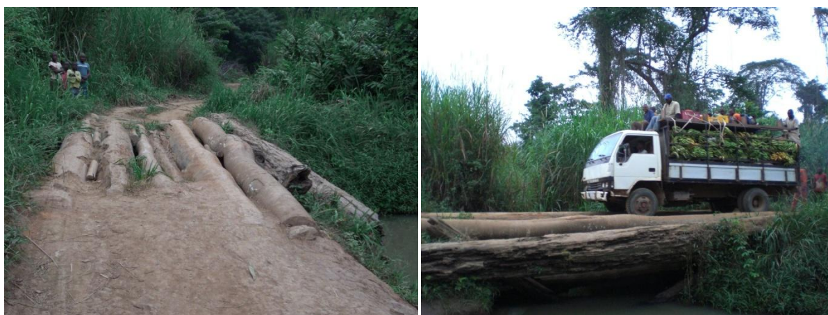
PHOTOS 72 : FRANCHISSEMENT D'UN PONT À MABOMBO (2010).
