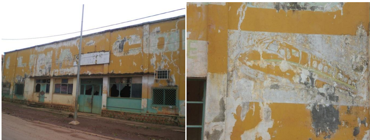
PHOTOS 64 : ANCIENNE AGENCE LINA-CONGO À DOLISIE (RUE CIAVALDINI, PHOTO 2009).
