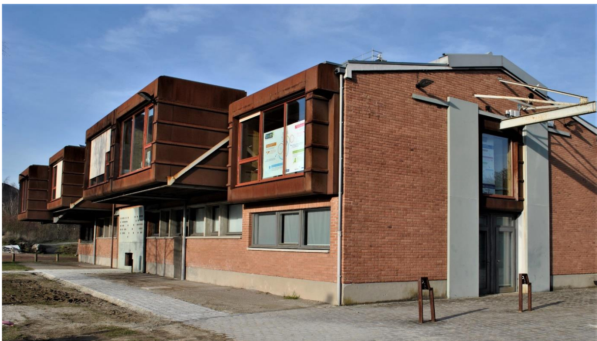
Figure 76 : Bâtiments du CR2E, Base 11/19, Loos-en-Gohelle (62)
