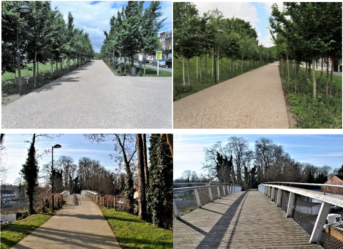
Figure 60 : Promenade plantée à partir de la gare et passerelle enjambant la rue Paul Bert
