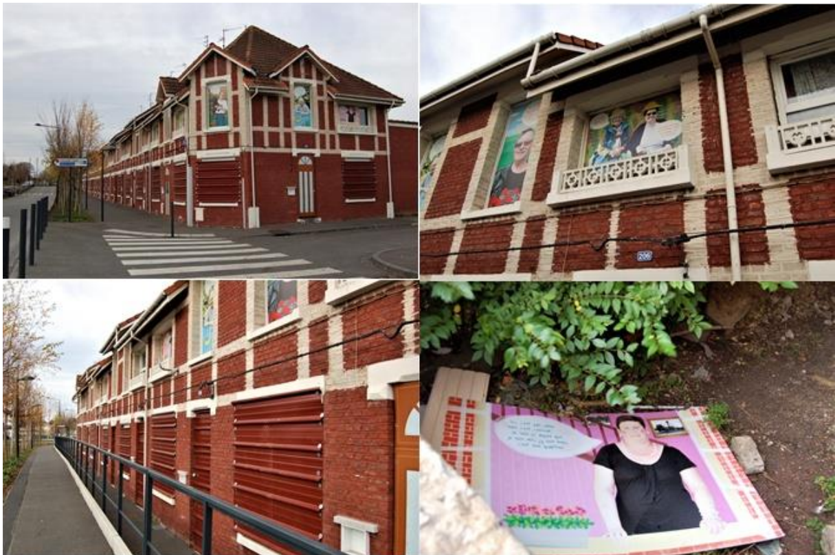
Figure 126 : Habillage des façades et concertation de l'îlot Parmentier
