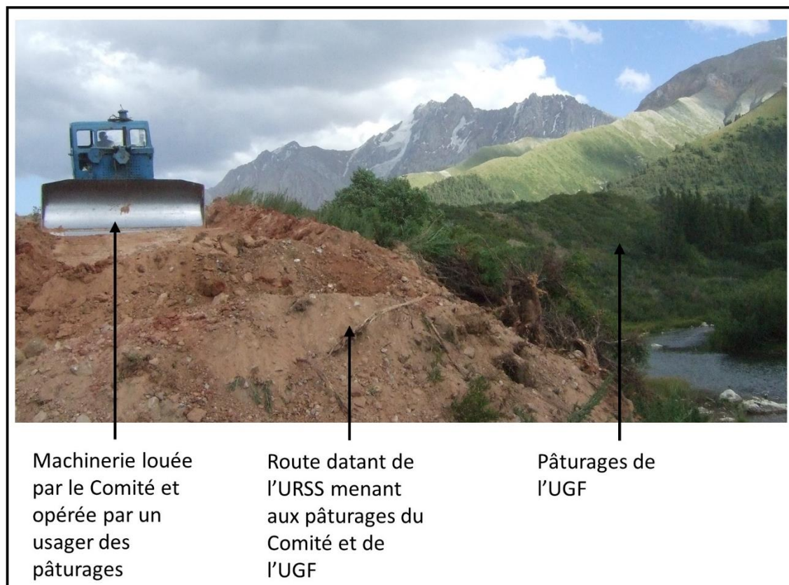
Figure 67 : Travaux de rénovation d'une route construite initialement à l'époque soviétique, menés par le Comité des pâturages de la commune de Žerge-Tal, pour faciliter l'accès aux pâturages de Čong Taš dont une partie est gérée par l'UGF et l'autre par le Comité des pâturages, 20 août 2012
