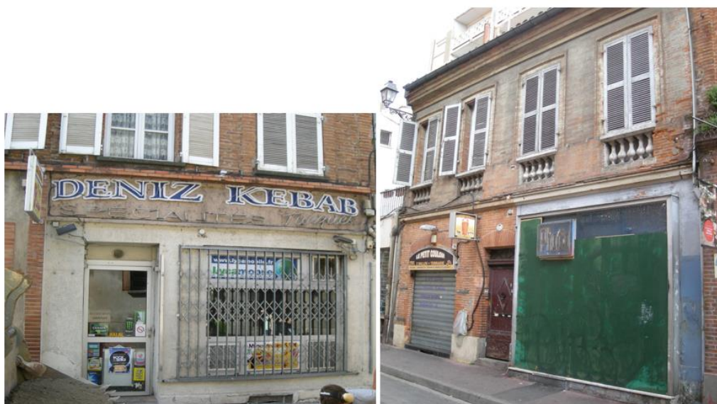
Figure 96. Locaux rue Pargaminières (photos issues du diagnostic commerce).
