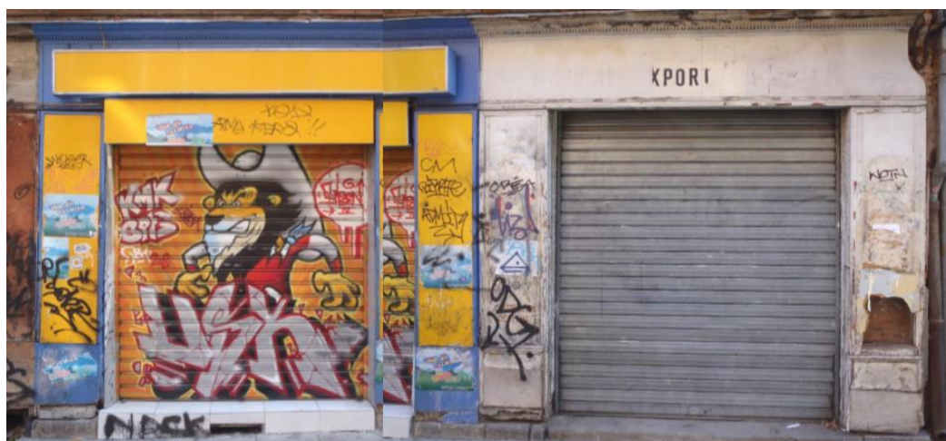
Figure 94. Locaux vacants, rue Gatien Arnould, janvier 2013 (source : SCCEP).
