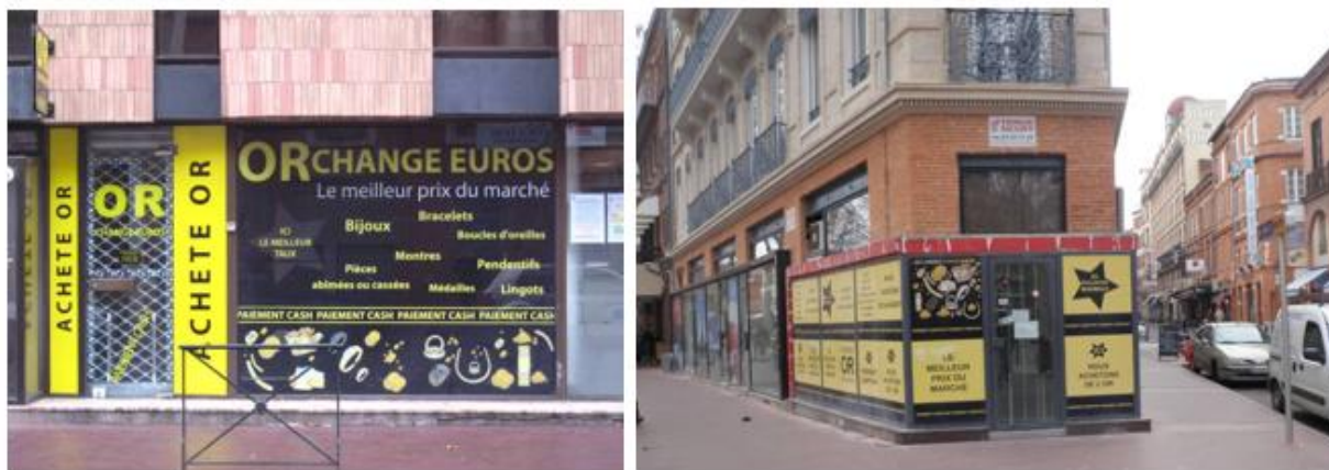
Figure 69. Les boutiques d'achat d'or : une esthétique dénoncée par les techniciens municipaux (source : photos du service SCCEP)
