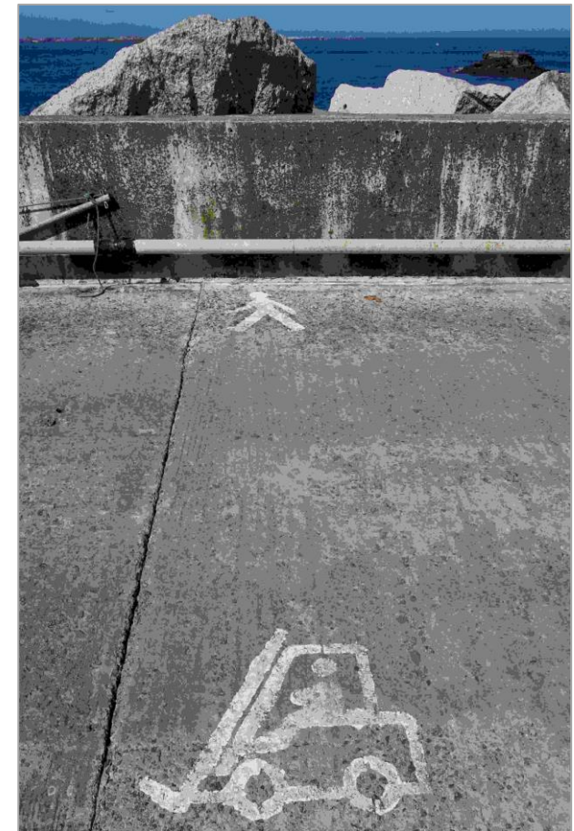
Figure 196 – Marquages au sol pour séparer les flux de marchandises et de passagers sur la Digue du bon Retour, Molène (Crédit MG 2016)
