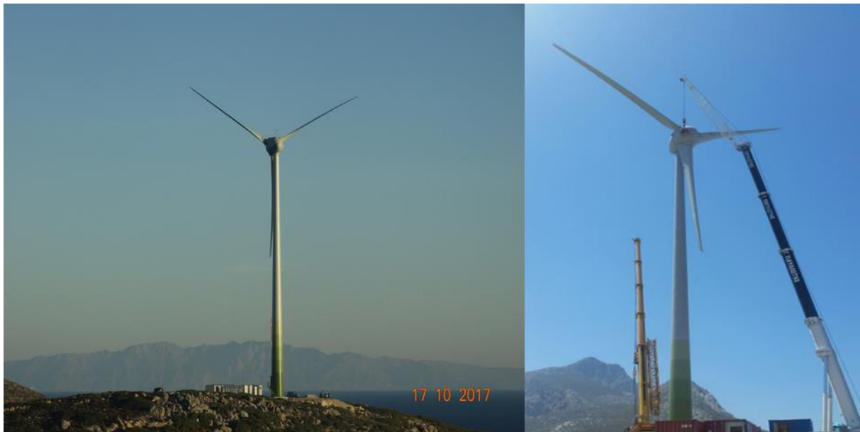
Figure I-13: Eolienne sur son emplacement sur l'île de Tilos (source : Facebook "Tilos horizon")
