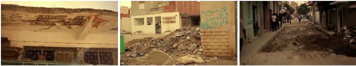
Fig. 101 Captures d'écran. Vidéo-clip de Houmani de Hamzaoui Med Amine et Kafon : des habitations endommagées, des gravats, des rues trouées et non-goudronnées [RAP8] @.
