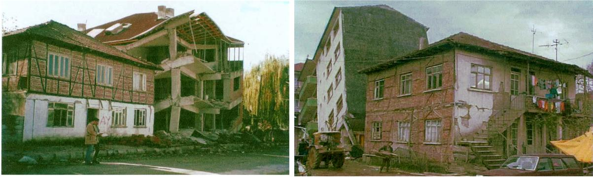
FIGURE 3.6 – Turquie : deux exemples de deux structures adjacentes. D’après [Doğangün et al. \[2006\]](#)
