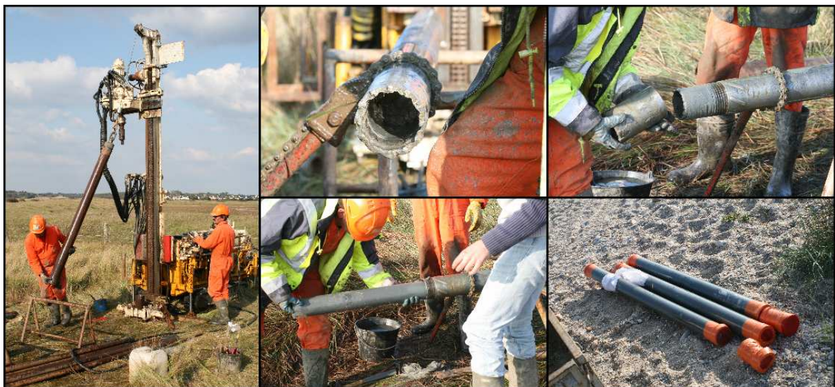
Figure II.6 : Dispositif du rotocarottier mis en œuvre par la société Fugro.
