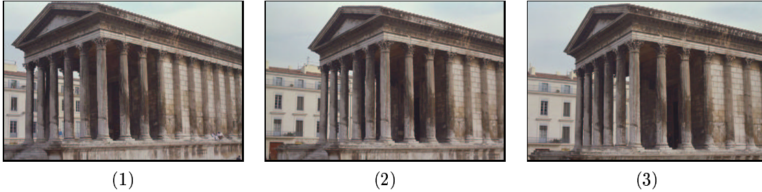
Figure 8.7 – Vues de la Maison Carrée utilisées.
