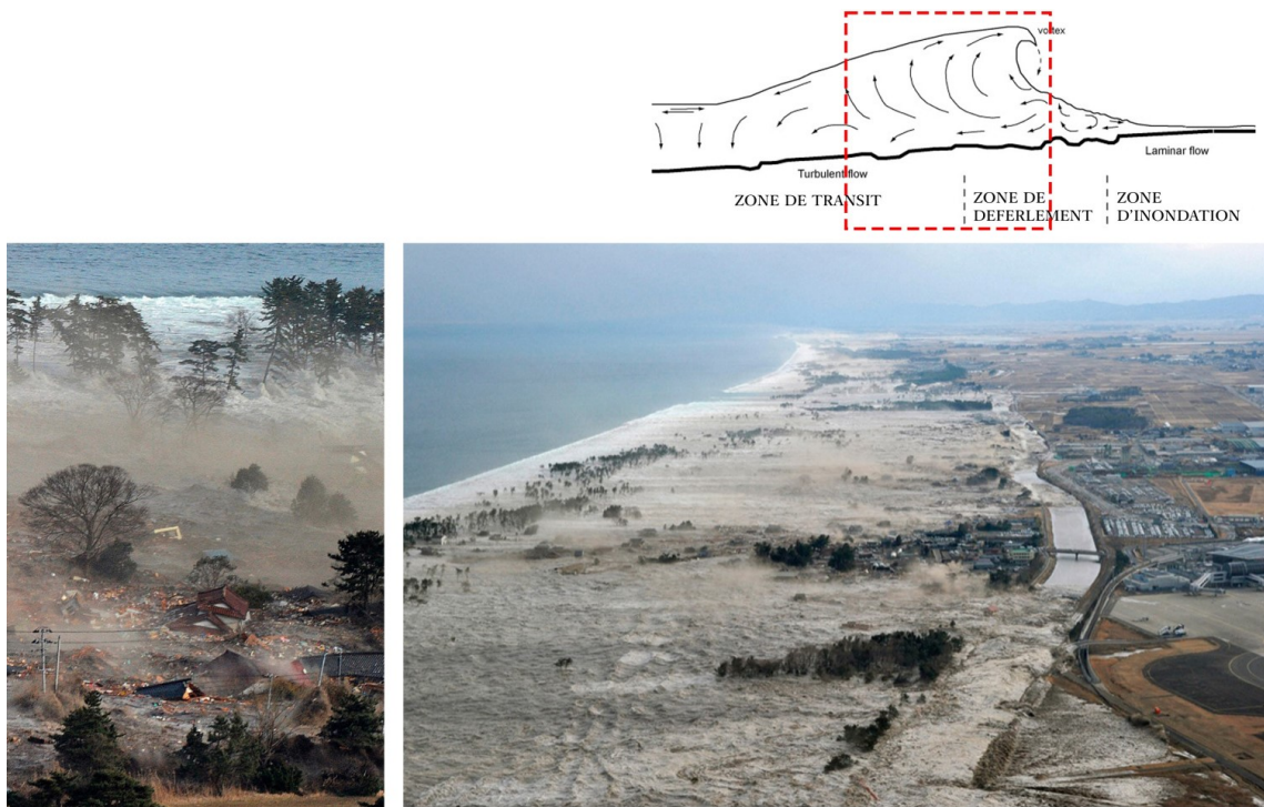
FIGURE 1.20 – Destruction de la végétation littorale : Aéroport de Sendai, Japon, tsunami du 11 mars 2011.
