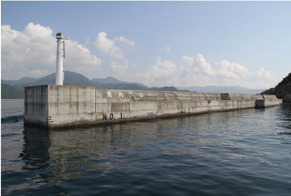
FIGURE 3.4 – Brise-lames au large du front de mer à Nobeaka, Japon. Situés aux embouchures des ports ou des zones à enjeux, afin de provoquer le déferlement et donc la perte d'énergie du tsunami.
