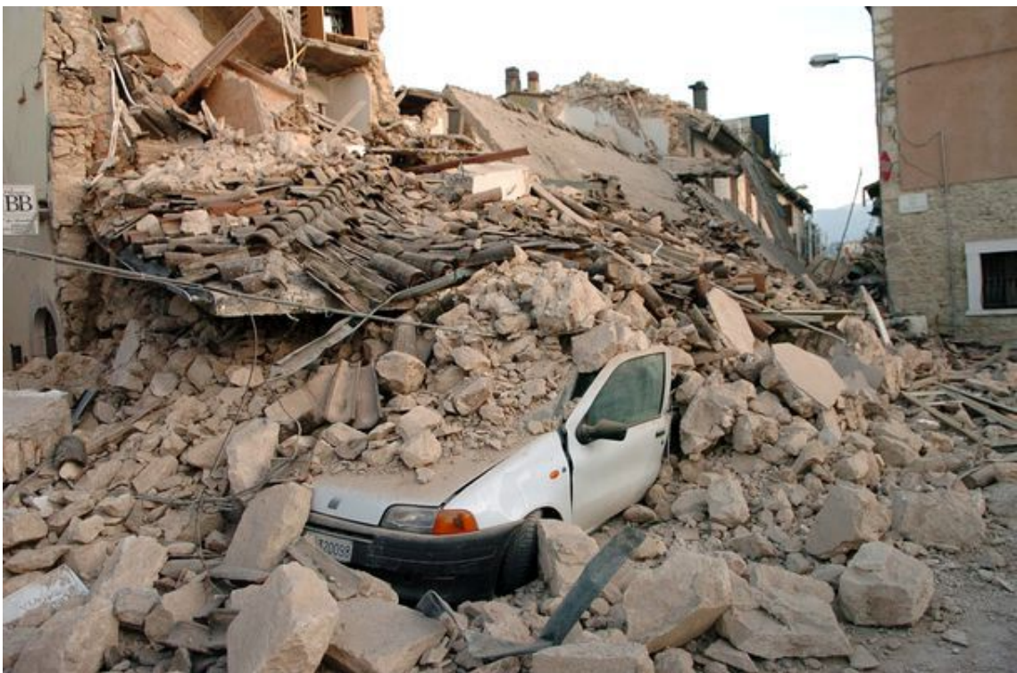
FIGURE 5.1 – Photographie de dommages suite au tremblement de terre de l'Aquila (Italie) en 2009.
