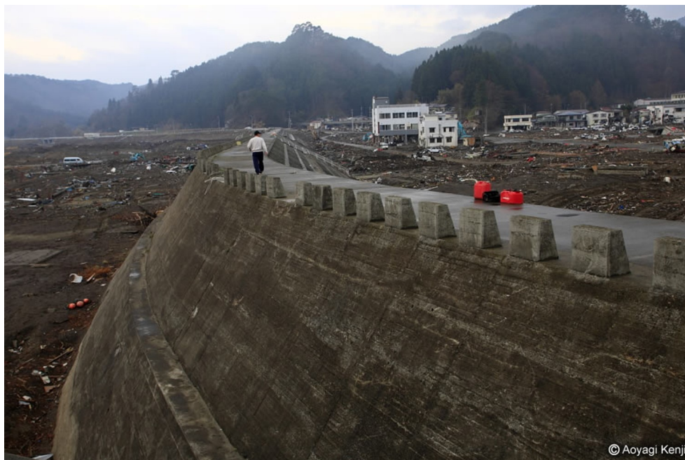
FIGURE 3.6 – Digue après le passage du tsunami du 11 mars 2011 à Miyako, Japon. Le tsunami a franchi la digue dévastant les bâtiments protégés, à l'arrière de la digue. Sources : Aoyagi, K., 2011.
