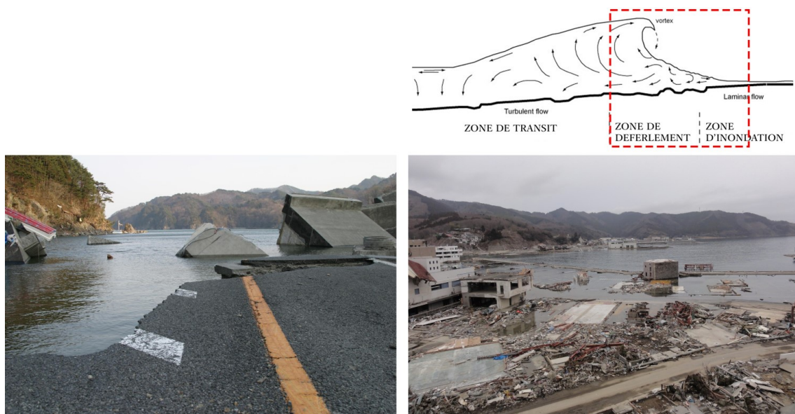
FIGURE 1.19 – Affaissement – ou subsidence – et tassement des sols : Kensenuma, Japon, tsunami du 11 mars 2011.
