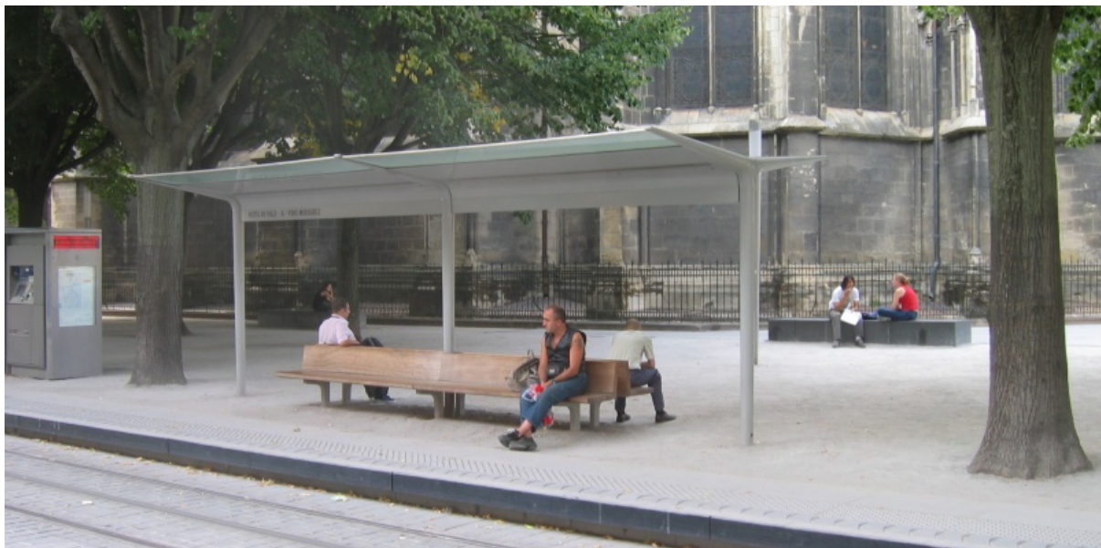
Un exemple de « station portique » à Bordeaux
