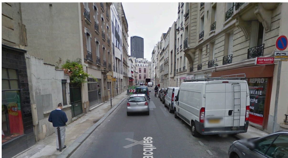
Figure 42 : Un peu plus haut dans la même rue, au moment du chantier : le plot sert aussi à s'appuyer... 197
