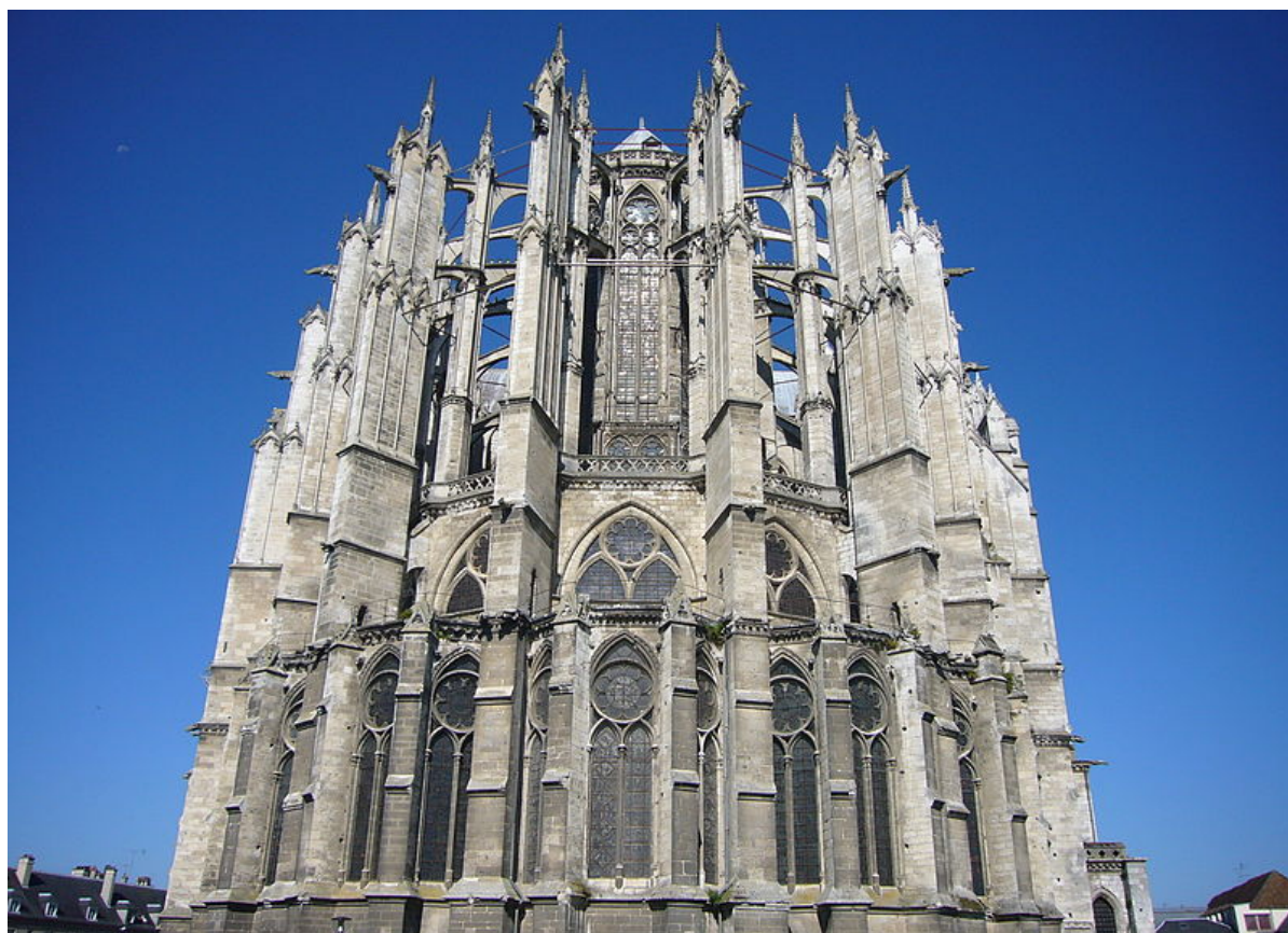
Figure 45 : A quoi servent les liens métalliques que l'on peut apercevoir en haut de l'édifice joignant les éléments verticaux entre eux ?
